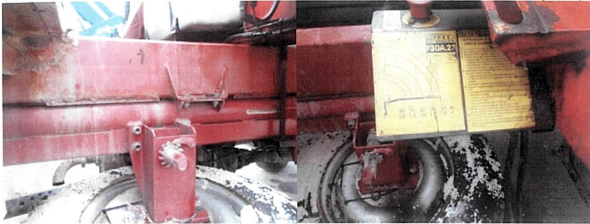
Figura 6: telaio e controtelaio durante le ispezioni
