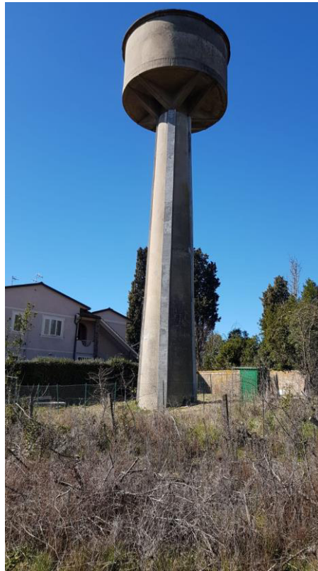
Vista del serbatoio e dell'area circostante
