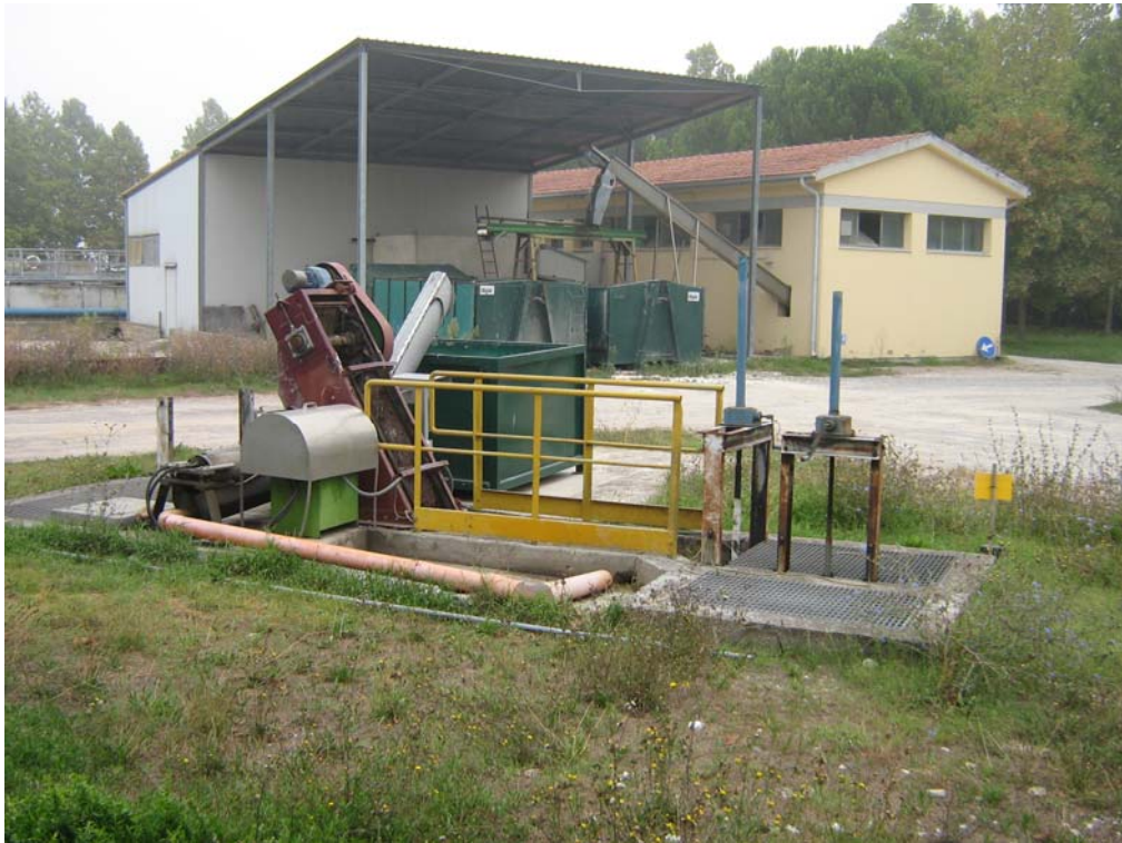
Foto 1 Pozzetto arrivo liquami e grigliatura grossolana
