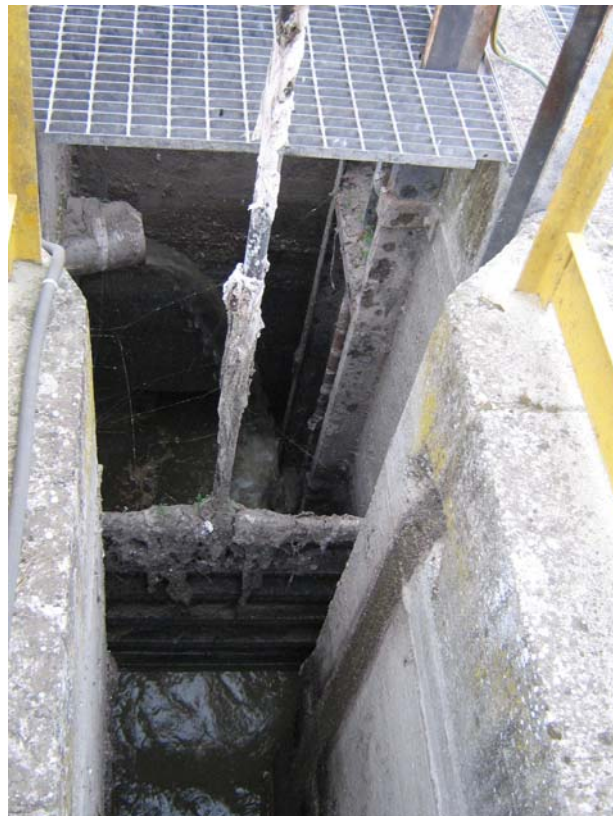
Foto 2 Grigliatura grossolana, in secondo piano tubazione di ricircolo nastropressa
