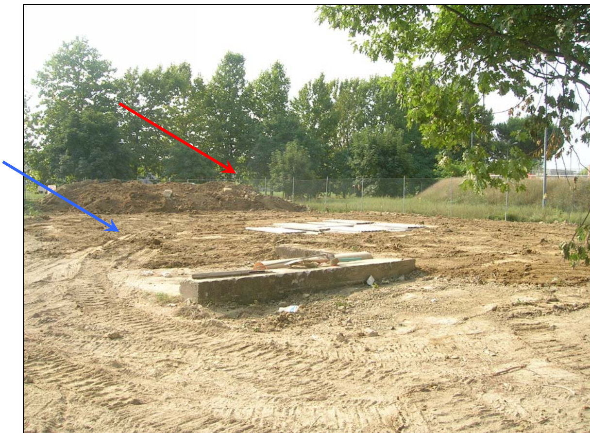
Area di stoccaggio terre e rocce da scavo (freccia rossa), superficie disponibile 50 mq; area ubicazione pozzetto di grigliatura (freccia blu).
