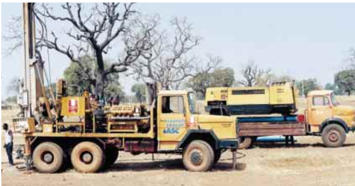
Il cantiere di perforazione a Manga.
